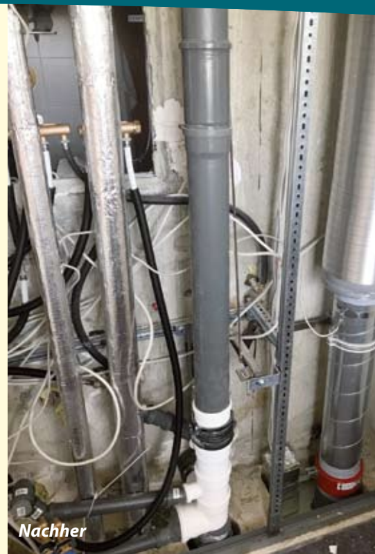
neue Medienversorgung nach Strangsanierung Schlesische Straße 71-75
